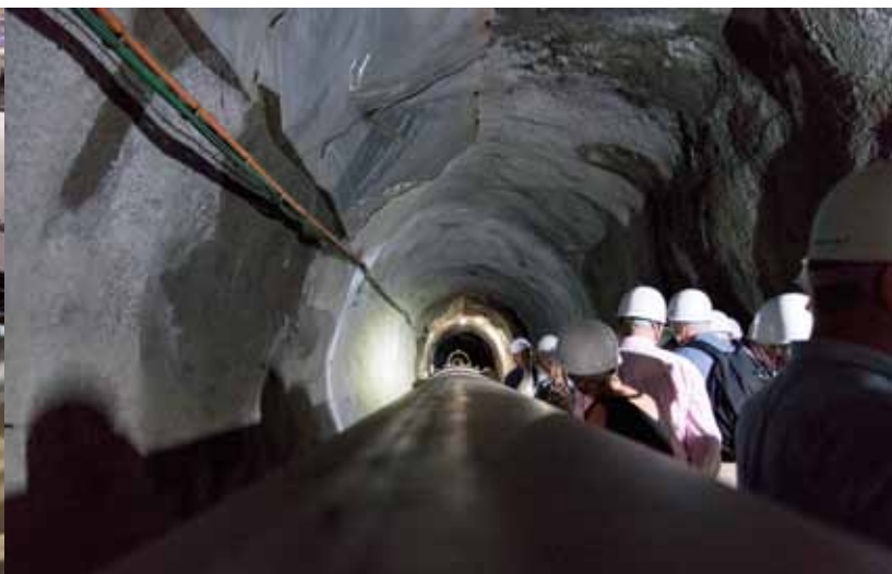
Bezoek aan een tunnel met daarin een van de twee 3 kilometer lange vacuümbuizen.
