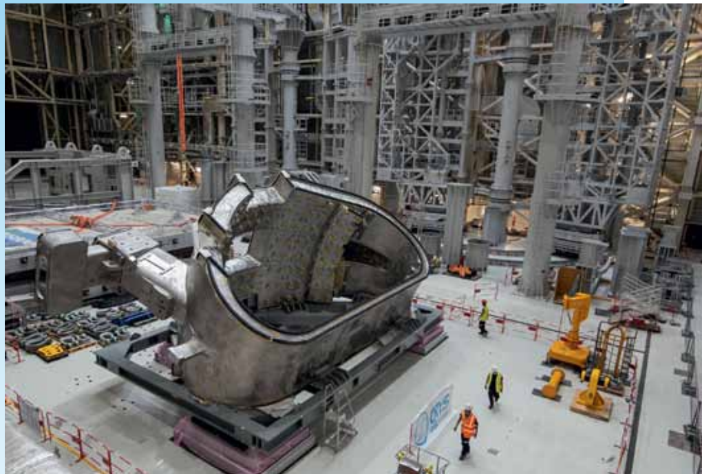
Het eerste segment van het vacuümvat in de montagehal van ITER. © ITER Organization, www.iter.org
